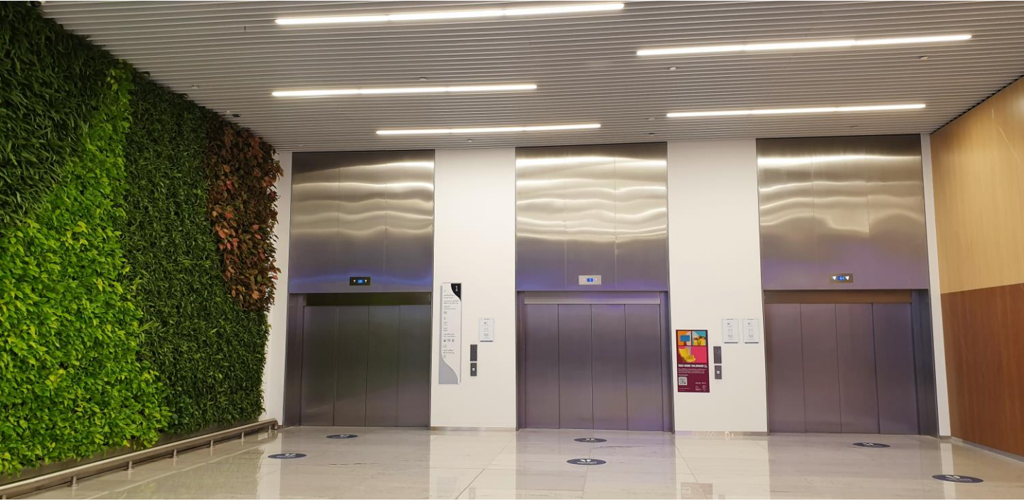
SS Lift jamb cladding
